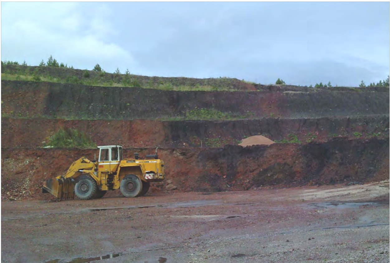
Abbildung 3. Deponie „Halde Richardschacht – Grünbach (Österreich)“ – Rückbau und Verwertung des Materials
