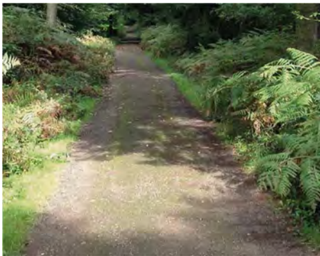
Bild 8: Leichter Abtrag der Deckschicht (3/8 mm) bei Gefällestrucken im Bereich der Fahrleiße
