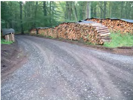
Bild 3 und 4: Auftragen der Tragschicht aus LD-Schlacke 0/32 mm und mit fertiggestellter Deckschicht, hier LD-Schlacke 0/3 mm
