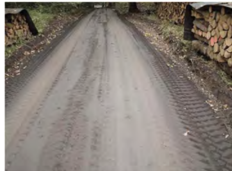
Bild 3 und 4: Auftragen der Tragschicht aus LD-Schlacke 0/32 mm und mit fertiggestellter Deckschicht, hier LD-Schlacke 0/3 mm
