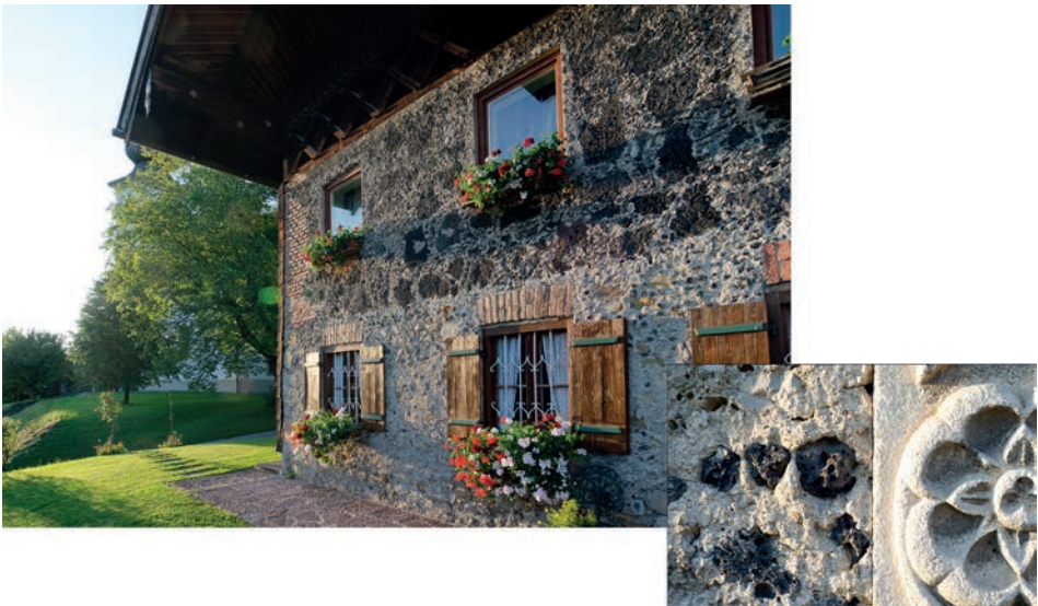
Bild 7: Bauernhaus mit Schlacke im Mauerwerk
