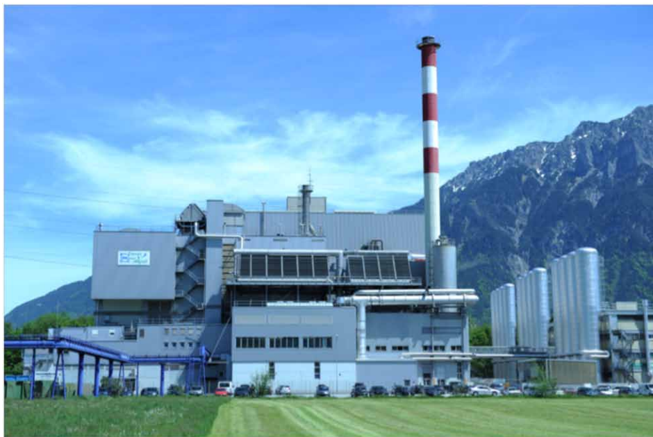
Bild 4: KVA Buchs mit 12 Wärmespeichern
