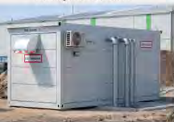
Containervariante für Unter- bringung der Löschanlage
