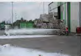
Schaumausbringung aus Wandhydrant
