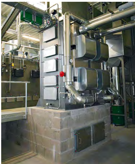
Bild 6: Doppelter Wärmetauscher-turm (WTT) mit Reinigungsöffnungen und Pumpe für den Wasser-Glykol-Kreislauf
