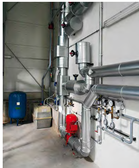
Bild 6: Doppelter Wärmetauscher-turm (WTT) mit Reinigungsöffnungen und Pumpe für den Wasser-Glykol-Kreislauf
