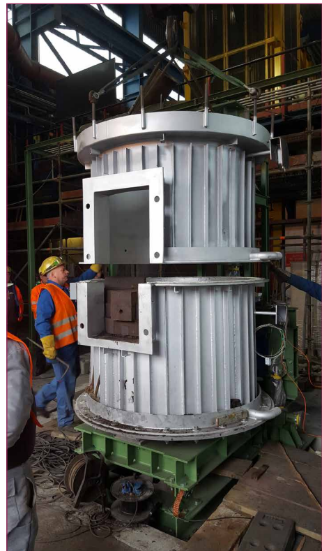
Bild 7: Montage eines kippbaren Kleinofens aus der Submerged Arc Furnace - Produktfamilie
