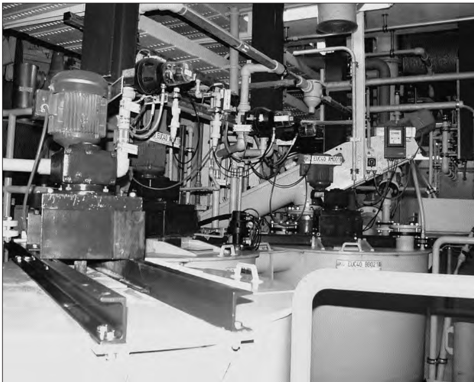
Bild 5: Rührkesselkaskade zur Extraktion der Flugstäube
