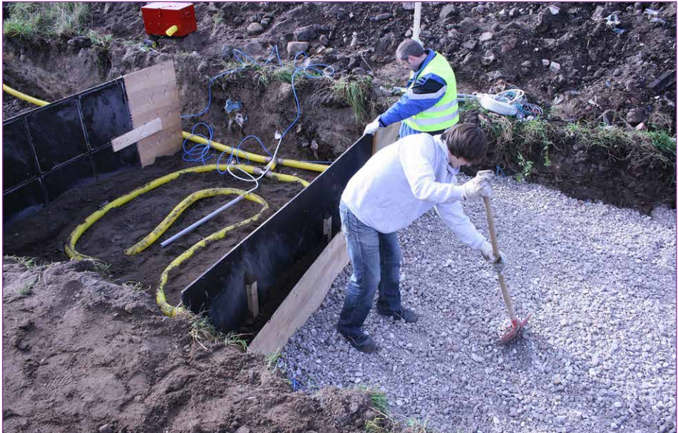
Bild 6: Aufnahme der Versuchsfelder 1 (rechts, mit Rezyklat gefüllt) und Versuchsfeld 2 (links, noch ohne Rezyklat)
