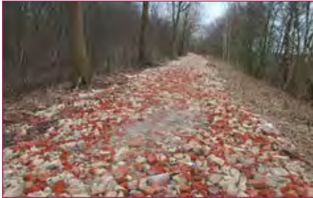
Bild 1: Unerlaubter Wegebau im ländlichen Raum mit unsortiertem Bauschutt
