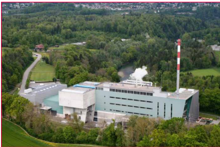
Bild 1: KVA-Anlage in Kanton Fribourg, Posieux
