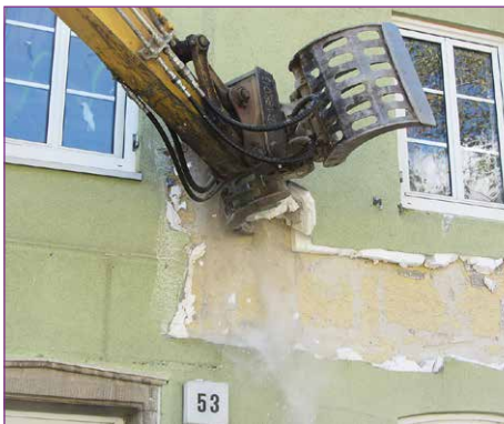
Bild 7: WDVS-Rückbau mit Bagger
