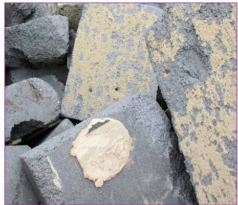
Bild 6: Putz und Kleberreste am Dämmstoff
