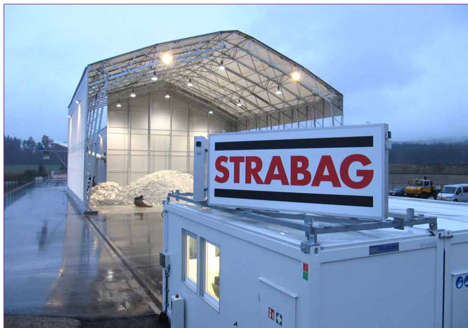
Bild 1: Aufbereitungsanlage in Deißlingen
