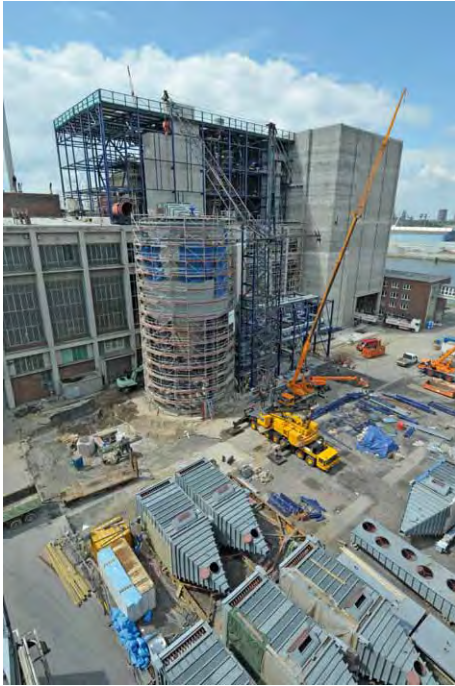
Bild 2: Vormontagefläche, im Hintergrund Kesselhaus und Brennstoffbunker
