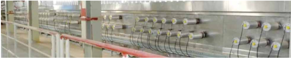
Bild 5: Klopfzylinder im Einbauzustand
