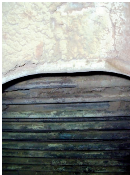
Bild 2: Kesseleinbauten nach der Sprengreinigung
