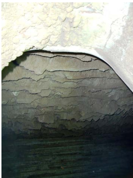
Bild 1: Kesseleinbauten vor der Sprengreinigung
