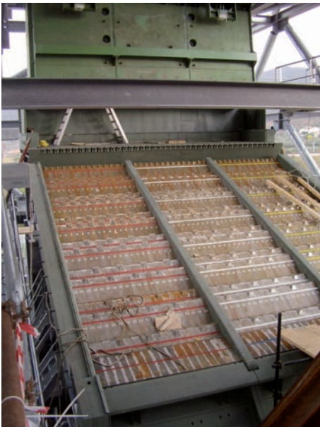
Bild 2: Montage des Rückschub-Rost Vario in der MVA Pozzilli, Italien
