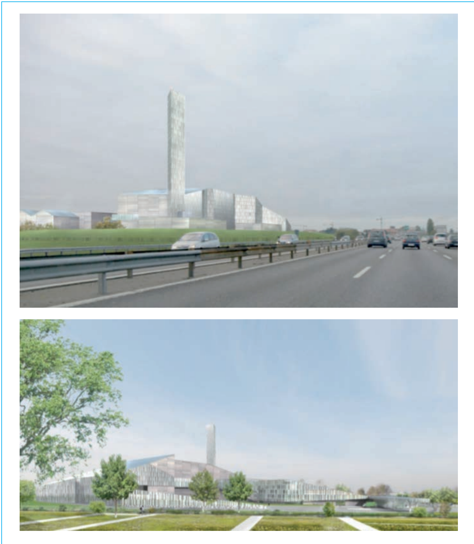
Bild 4: Architektonische Gestaltung der MVA Milano Sud
