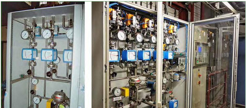
Bild 9: Misch- und Messmodule im ursprünglichen Zustand (links) und nach Umrüstung (rechts)
