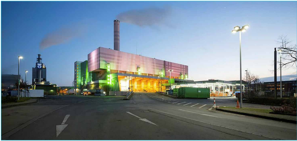
Bild 1: Ansicht der Müllverwertungsanlage Bonn
