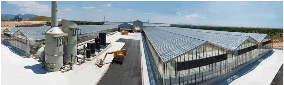
Bild 2: Großanlage für 600.000 EW zur solaren Trocknung von Klärschlamm in Palma de Mallorca
