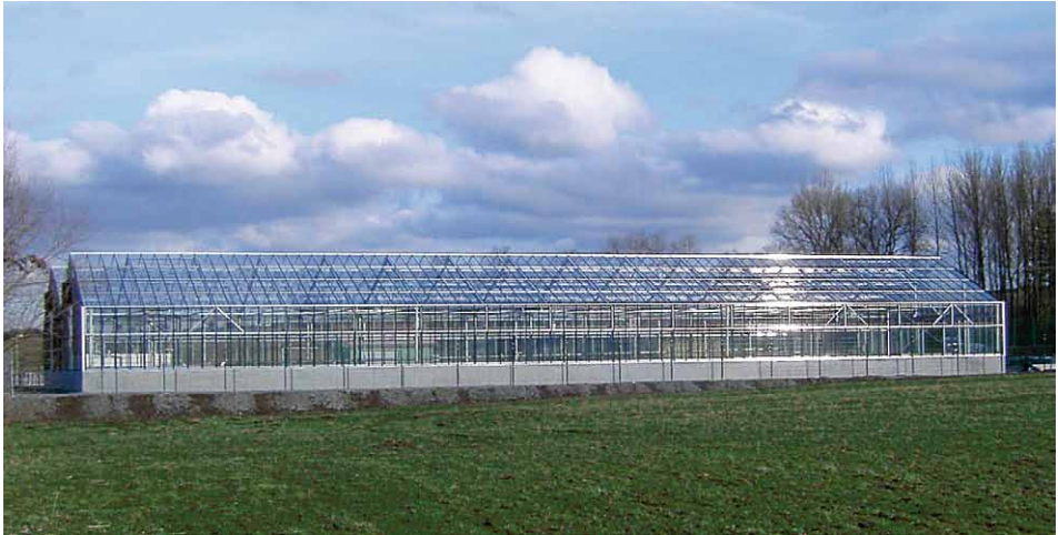
Bild 1: Solarer Speichertrockner mit kontinuierlicher Beschickung für etwa 6.000 t Nassschlamm
