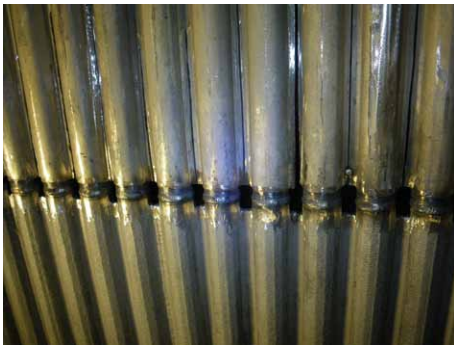
Bild 20: Anschluss an Inconel-Wände
