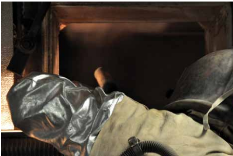
Bild 4 und 5: Online-Sandstrahlreinigung
