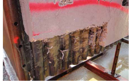
Bild 10: Testwand nach Versuchen mit Wasserstrahlhöchstdrucktechnik
