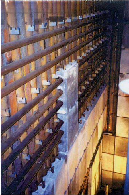
Bild 4: Wandüberhitzer MK II, MSB Schwandorf
