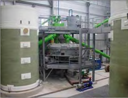
Bild 11: Vorbereitung der Lösung, Verwiegung der Reststoffe sowie Zugabe von Wasser und Additiven
