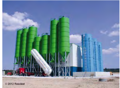
Bild 7: Die RESOLEST-Anlage in Rosières-aux-Salines (Frankreich)
