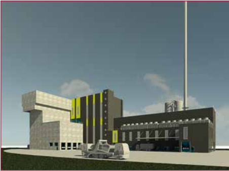
Bild 2: Ansicht von Osten, Blick auf die Annahmeschleuse (links) das Kesselhaus (Mitte) und das Abgasreinigungsgebäude (rechts)
