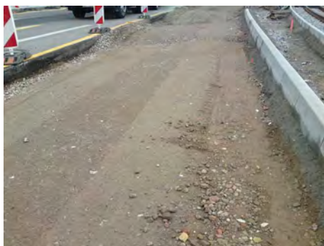
Bild 5: Frostschutzschicht aus RC-Material, eingebaut
