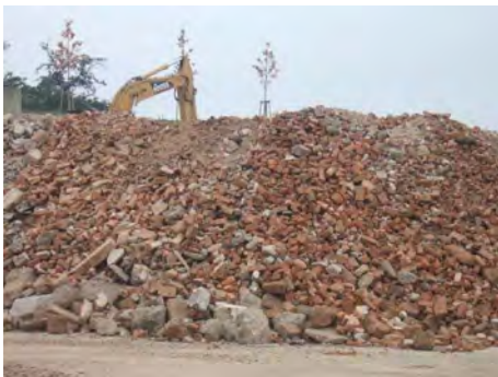
Bild 3: Ausgangsmaterial zur Herstellung der Ziegelkomponente einer Gesteinskörnung Typ 2
