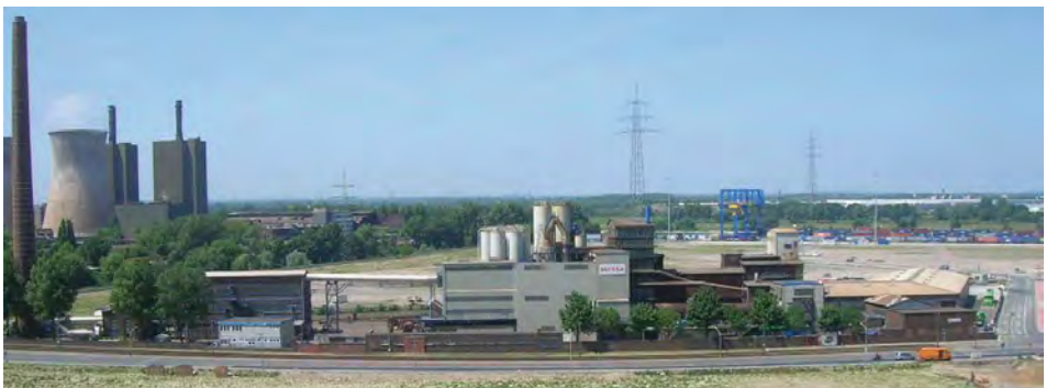
Bild 1: Wälzanlage Befesa Zinc Duisburg GmbH
