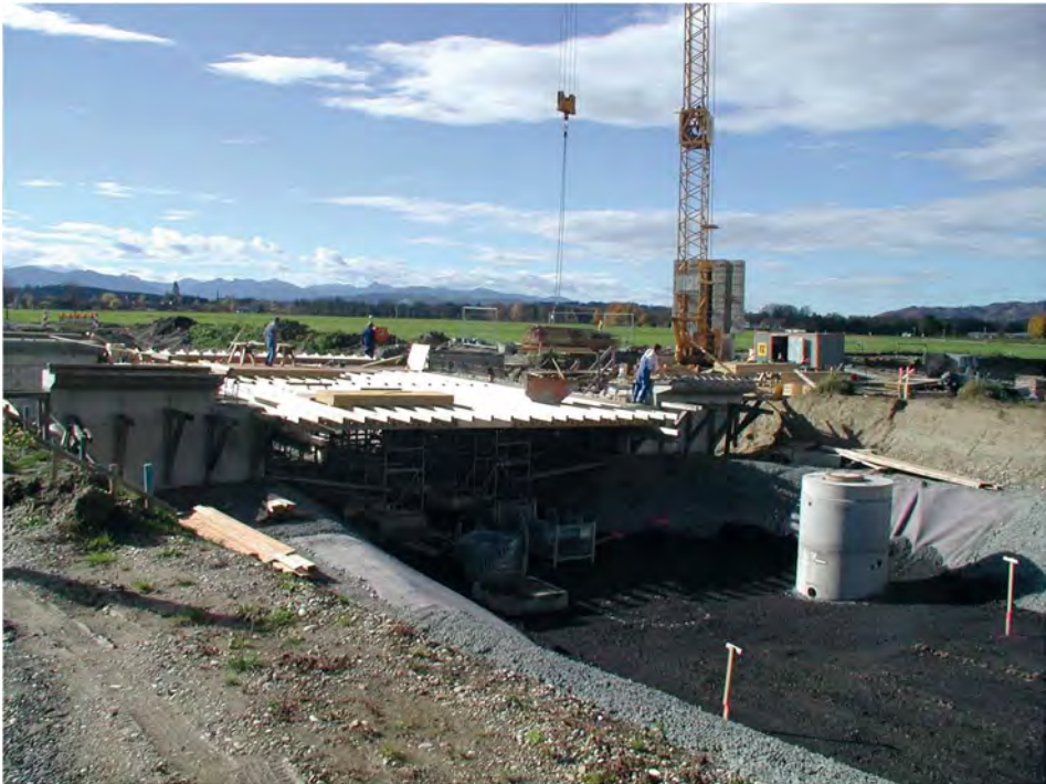
Bild 10: Einbau von Elektroofenschlacke als Ballastschicht
