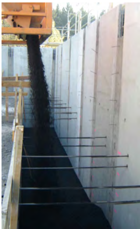
Bild 9: Einbau von Elektroofenschlacke als Strahlenschutz
